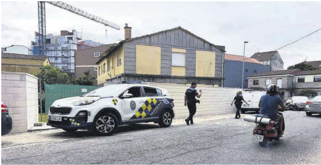
Agentes de la Policía Local de Cangas, supervisando la circulación rodada en un tramo en obras de la calle Longán. | G. Núñez
