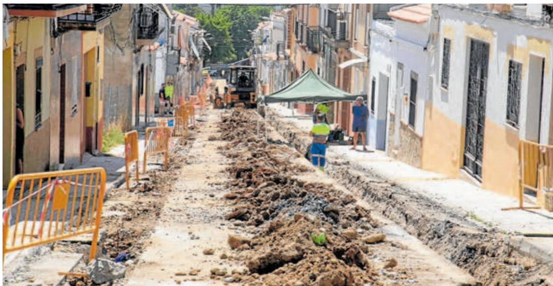
Zanja abierta en la barriada de San Juan, en el noreste de la ciudad, para la renovación de la red de abastecimiento de agua. J. M. ROMERO
